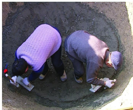
图3 池底施工示意
