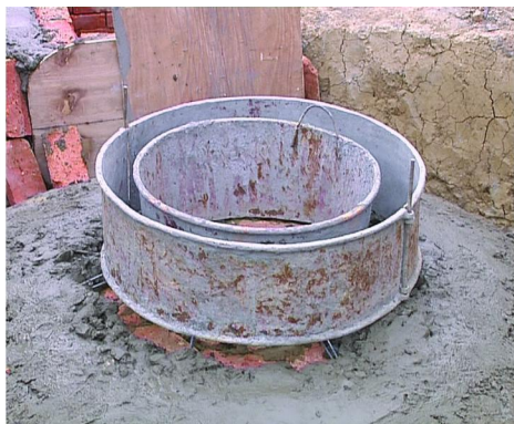
图6 活动盖口施工
