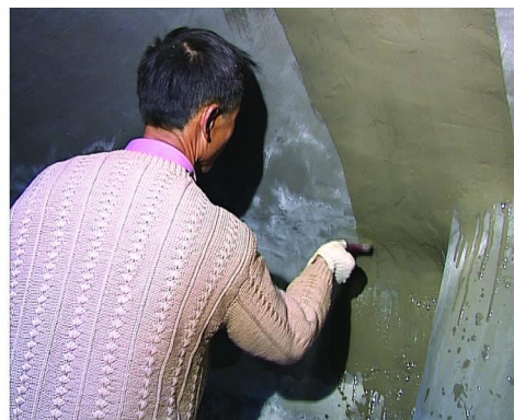
图9 密封层施工
