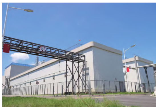
图1 本项目厌氧发酵罐体外形实体照片
