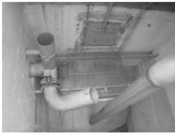
图6 带有可调弯头的紧急溢流管
